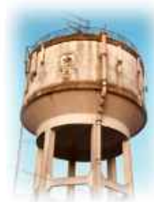
Figura 4.8: El volumen de un Reservorio puede ser calculado por el segundo teorema de Pappus y Guldinus
