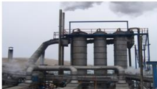
PLANTA DE AGUA DE COLA
