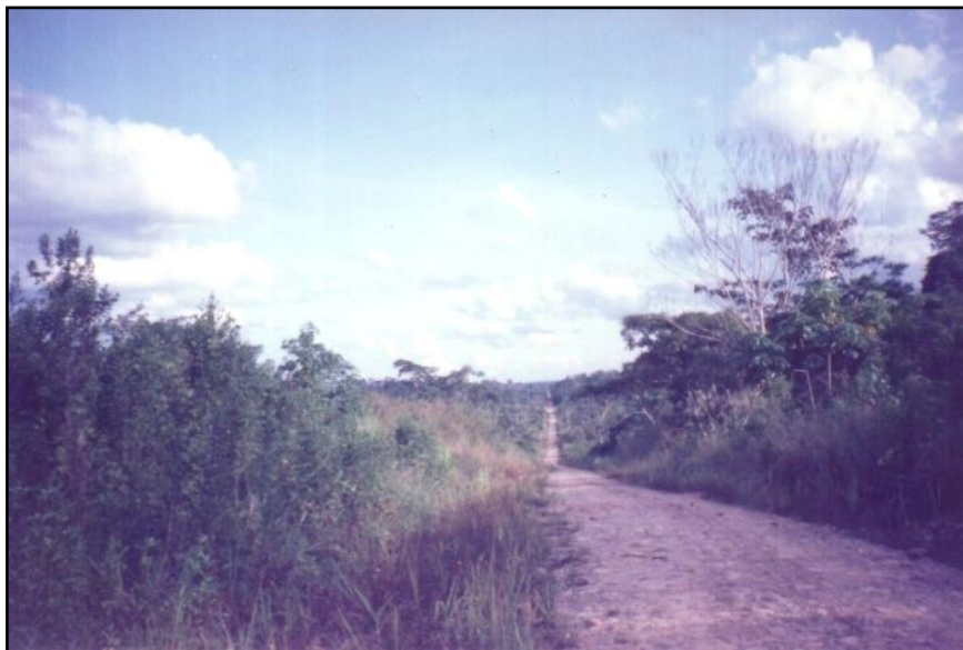
Figura 14. Carretera Marginal de la Selva en sus inicios y debidamente afirmada
