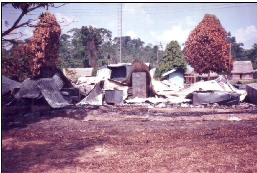
Figura 16. Oficinas del PDR VHP destruida por el ataque de Sendero Luminoso en 1993
